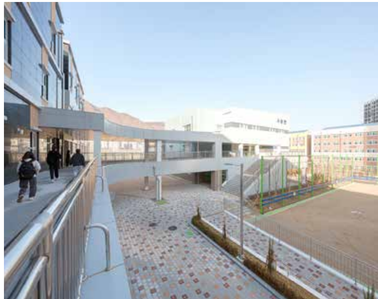
사송고등학교 중앙 연결 통로가 이어진 전경
