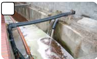
공장 폐수 무단 방류
