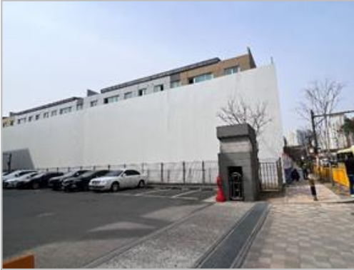
가설울타리: 작업장의 비산먼지를 차단하고 가설재의 용도로 사용하며 보행자의 통행 안전을 확보하여 안전사고를 미연에 방지하는 울타리
