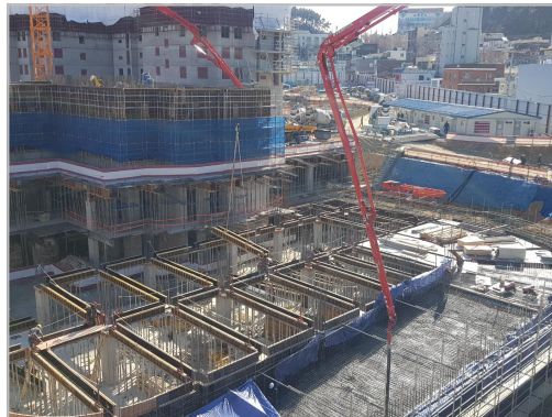
콘크리트 타설: 건물을 지을 때 구조물의 거푸집과 같은 빈 공간에 콘크리트 따위를 부어 넣음
