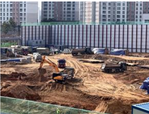
터파기: 구조물 건설 시 기반을 닦기 위해 흙을 파내는 작업
