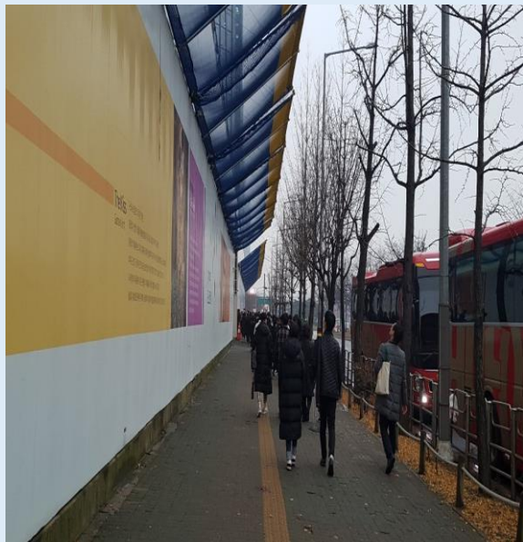
통학로 낙하물방지망 설치 상태
