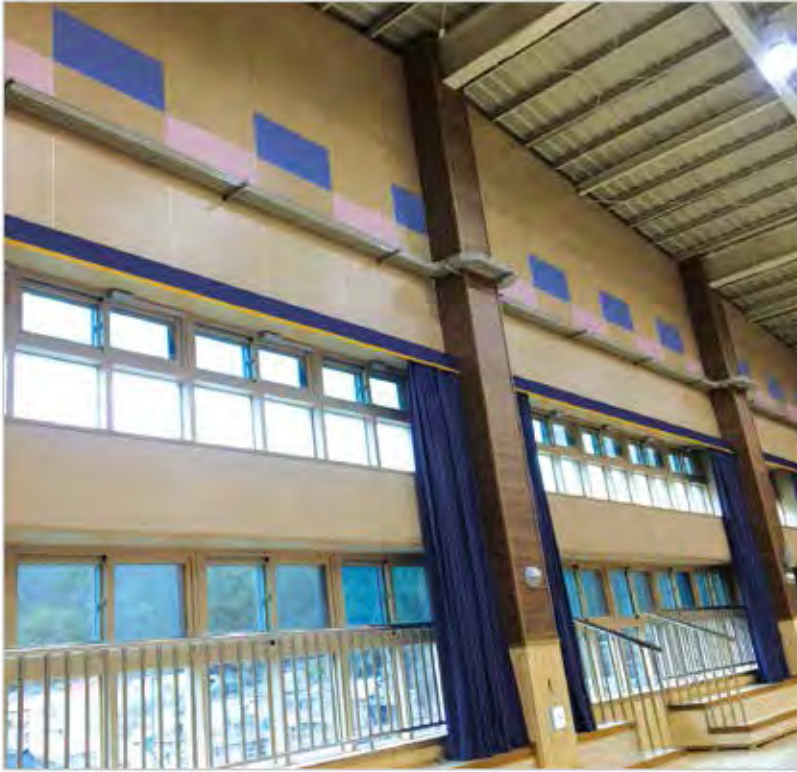
체육관 전기배선 사전에 충분한 협의로 매입설치를 했으면 하는 아쉬움이 많은 부분
