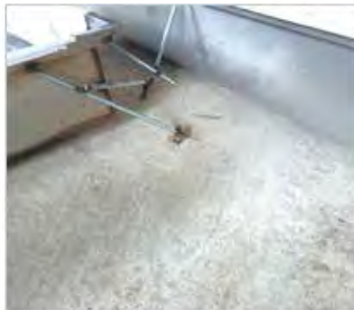
주방의 벽체 액체방수 뿐만 아니라 바닥의 트렌치 설치 고정부분은 우레탄방수를 하여 2중 방수를 한다.
