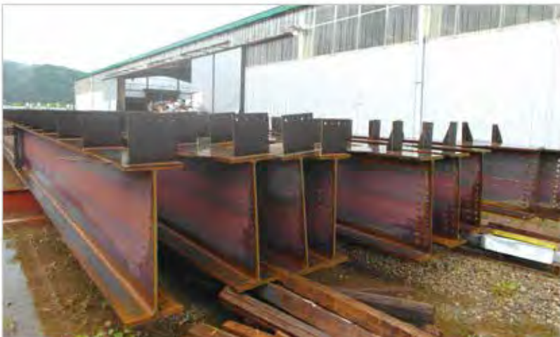
철골재료를 확인하기 위해 재료에 부착된 사양서, 마크를 확인할 뿐만 아니라 밀시트를 검토한다.
