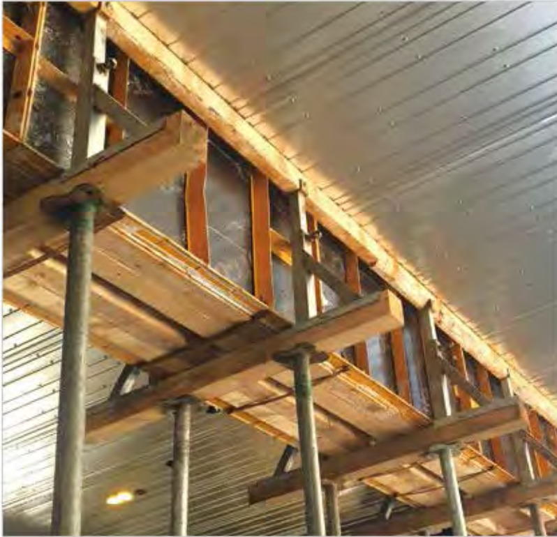
데크플레이트 전체 슬래브를 데크플레이트 구조를 적용 공기 단축의 효과를 볼 수가 있었다.
