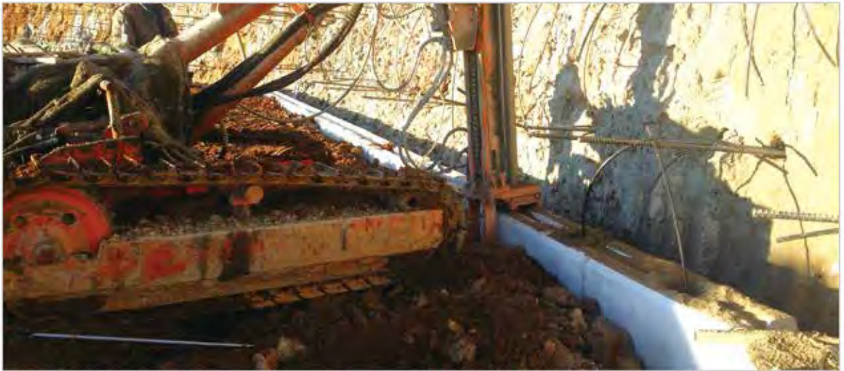
산을 깎아 대지를 조성함에 있어 토사의 붕괴 방지를 위한 토목공사에 적합한 PC패널 옹벽
