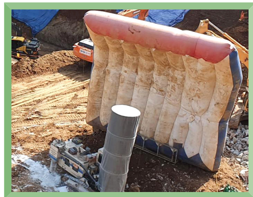
참고3. 이동식 방음벽 설치 위치 (공사 장비 근접+학교 방면)
