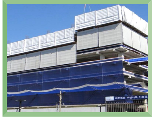
참고8. 건물 내 작업 층 방진막 설치
