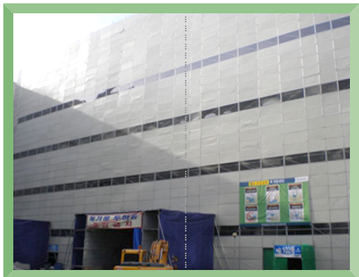
참고1. 철거 시 방진시설 설치
