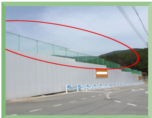
참고3. 방진벽 및 방진망 설치
